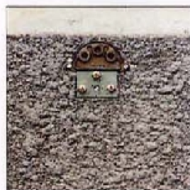
Plaque 3 trous ø 14 Buse ø 2,7 Plate 3 holes ø 14 Nozzle ø 2,7
