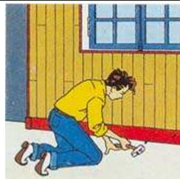
8. Entourez les fenestres avec des baguettes d'angle et clouez les plinthes sur les lambris.
