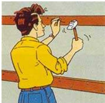
1. Fixez préalablement sur le mur des tasseaux (15x27mm) écartés de 40 mm MAXI
