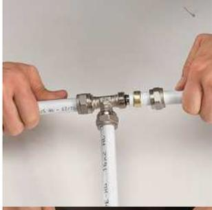
Raccorder les deux parties en insérant le tube sur le raccord jusqu'à refus.
