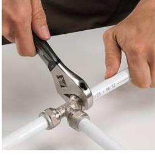
Visser l'écrou avec une simple clé à molette.
