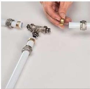
Étape importante : ébavurer parfaitement le tube puis emboîter l'écrou et la bague de compression à son extrémité.
