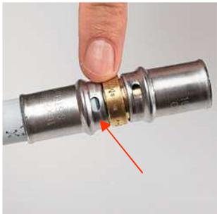
Insérer le tube parfaitement ébavuré dans le raccord à sertir jusqu'à le voir apparaître au niveau du témoin.
