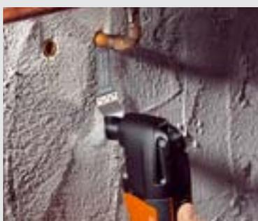
Idéal pour le démontage d'anciennes installations : avec les lames de scie universelles E-CUT, coupez les tuyaux au ras du mur pour un rebouchage ultérieur.
